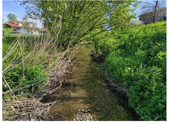
Abb. Bestandsaufnahme, 29.04.22- Röthenbach
